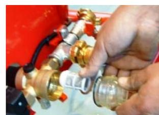
Nach der Reinigung des Filtereinsatzes ist die Gehäusekappe wieder aufzuschrauben.
