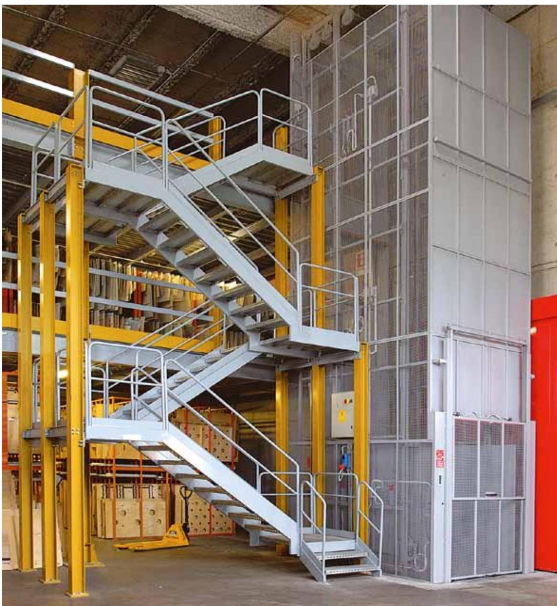
*Scale e montacarichi per soppalco a due piani di 1500 m<sup>2</sup>*
