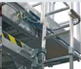
[ 2 ] Scala con fissaggio
